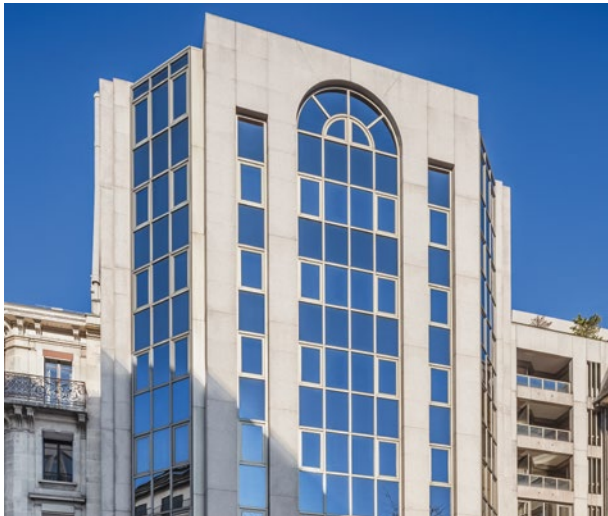
位于日内瓦 8 Place Camoletti 的银行大楼
