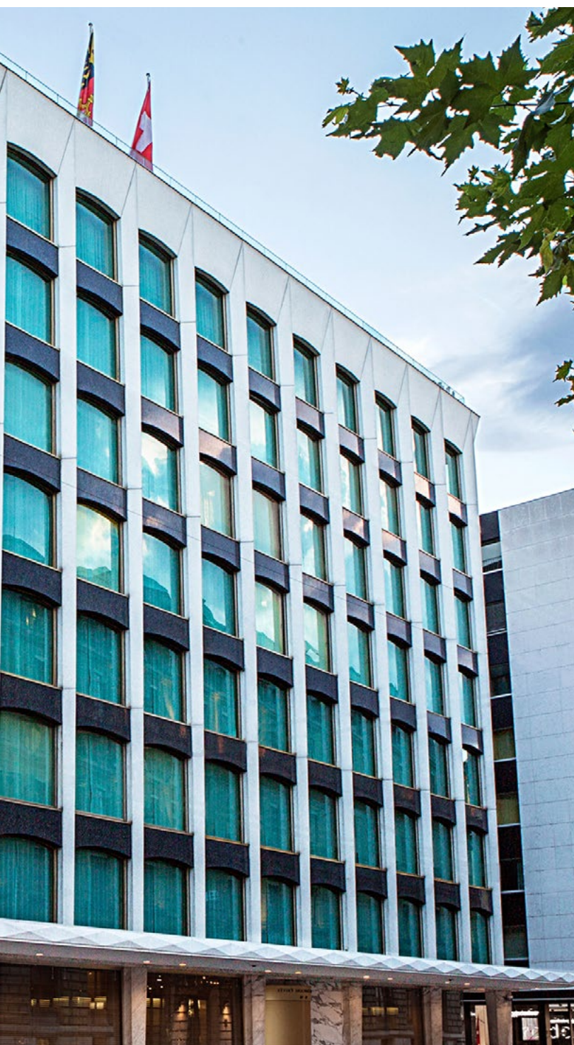
Bureaux UBP Genève, Rue du Rhône 96-98
