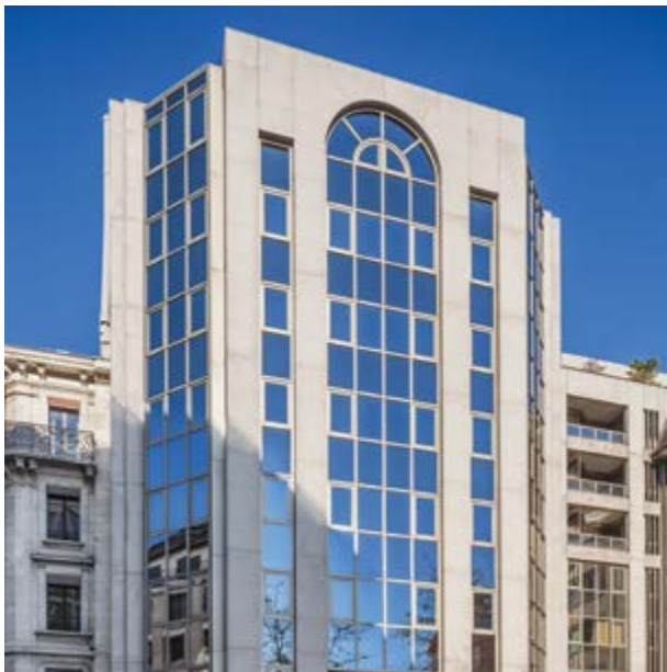
Bâtiment place Camoletti 8, Genève
